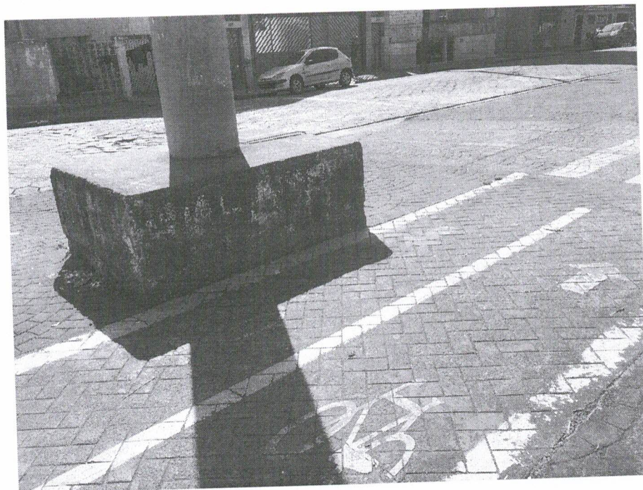
Base da Torres das Linha de Transmissão de Energia - CPFL
