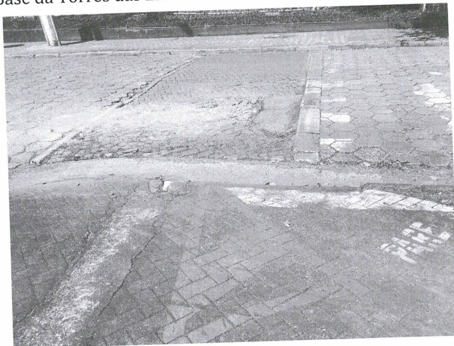
Manutenção no Leito Carroçável da Av. Henry Borden
